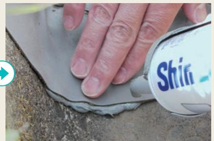
シーラントマスター300-Gを剥がれた箇所の深部まで充填させて押さえ付けます。⇒施工手順 6へ。
