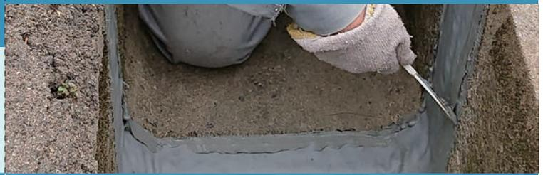
シーラント材が不足している部分は、シーラントマスター300-Gを補充します。補充した部分もヘラでならします。
