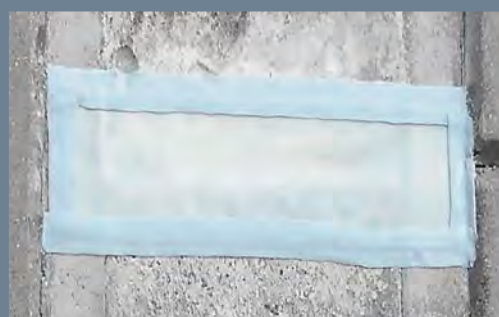
パッチシールクロス貼付後、 パッチテープで端部を処理した例。
