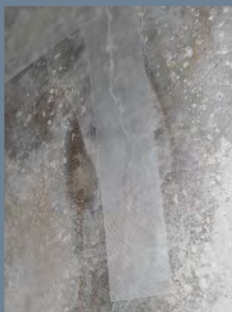
パッチシールクロス貼付後、 パッチテープで端部を処理した例。
