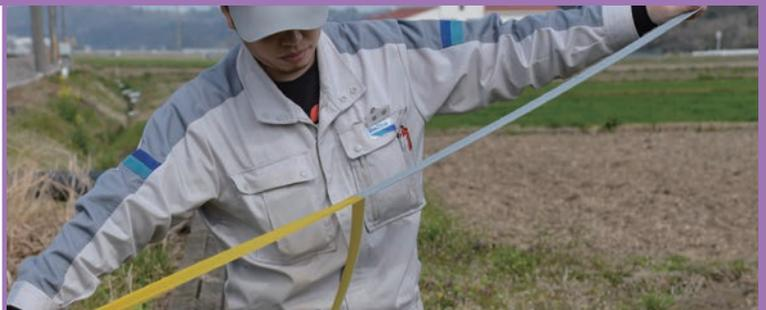
①粘着面を外側に二つ折りにし、両端部を持ち、シートの中央を敷設部の中央に合わせます。
