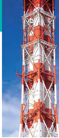
煙突の耐熱保護塗装
