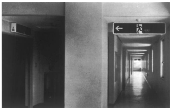
非常階段、非常口などの目地シール
