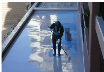
屋上への塗布
