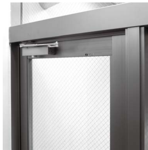
防火戸などの目地シール
