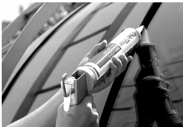
ポリカーボネート製アーケードの接着・シール
