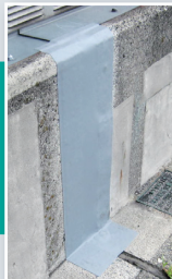
壁高欄縦目地(遊間)の防水シール
