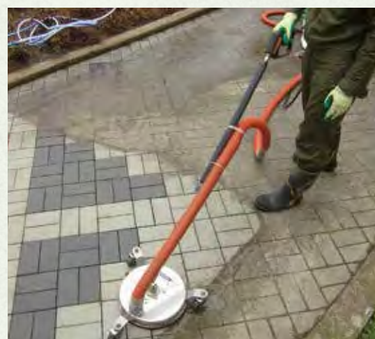
回収型高圧洗浄機による除染作業
