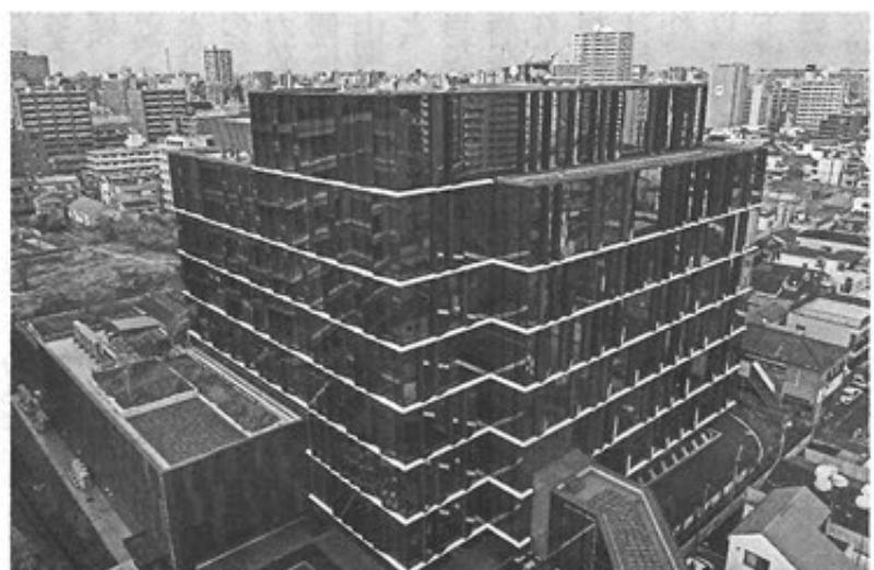
写真4 ダイレクトボンディング型4辺SSG構法を採用
