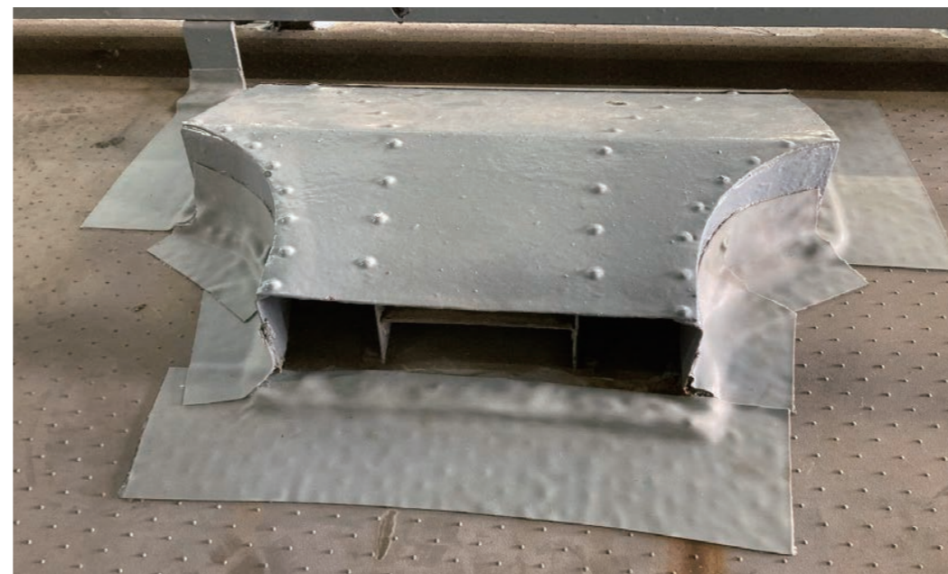
シンエツパッチシールを採寸し貼付
