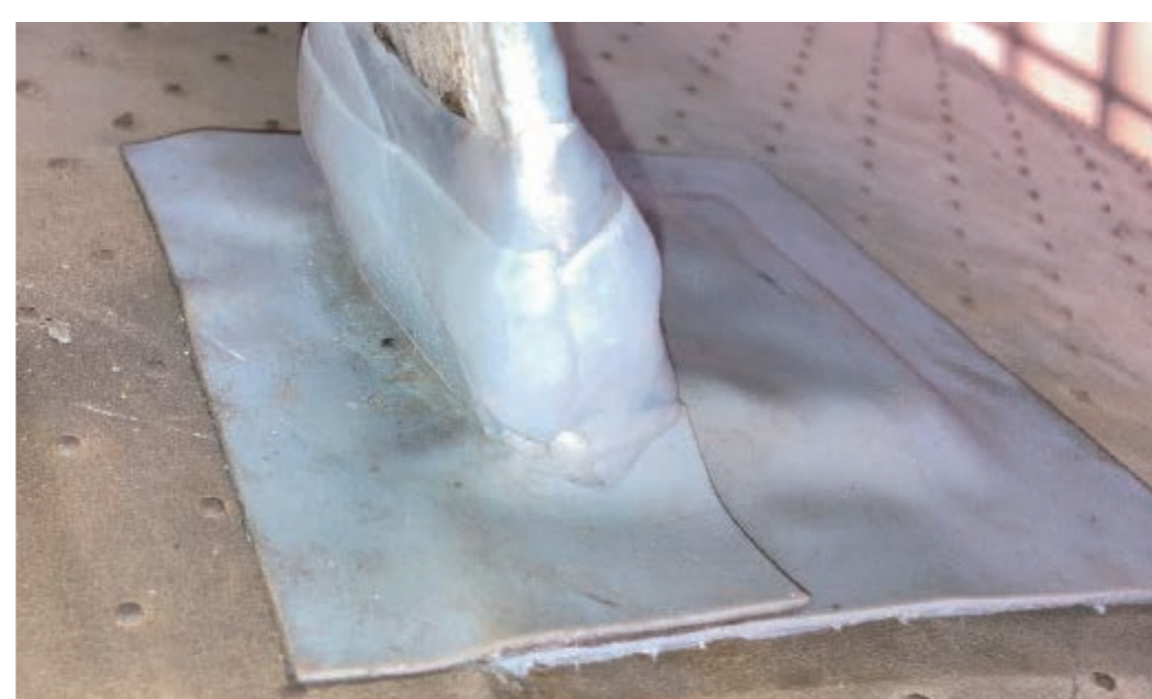
端部・重ね合わせ部にパッチテープトウメイを貼って完成
