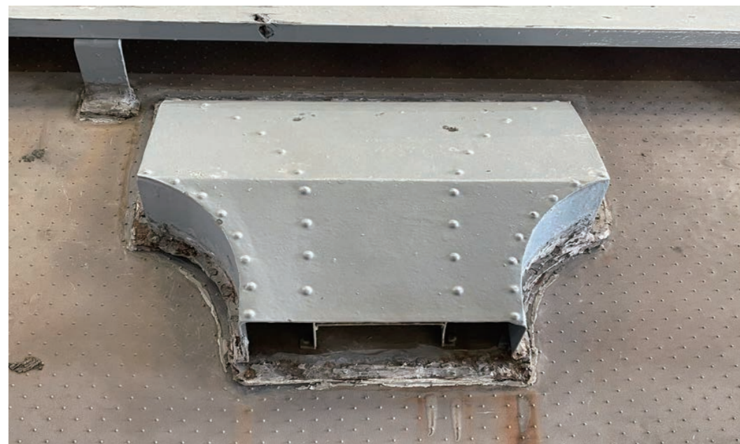
既設シール材の除去
