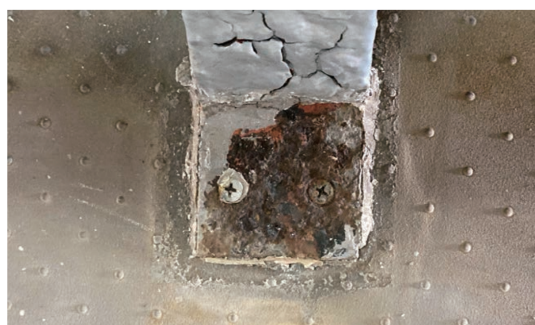
既設のシール材・塗装を除去
