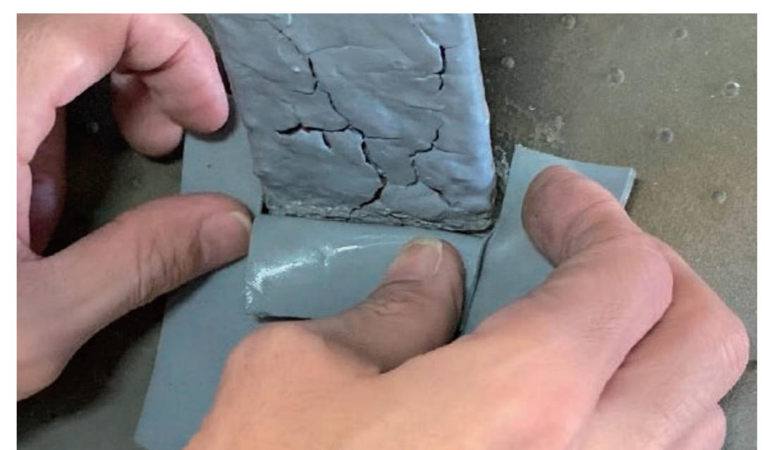
シンエツパッチシールを採寸し貼付
