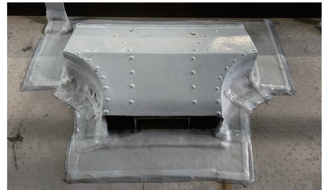
端部・重ね合わせ部にパッチテープトウメイを貼って完成
