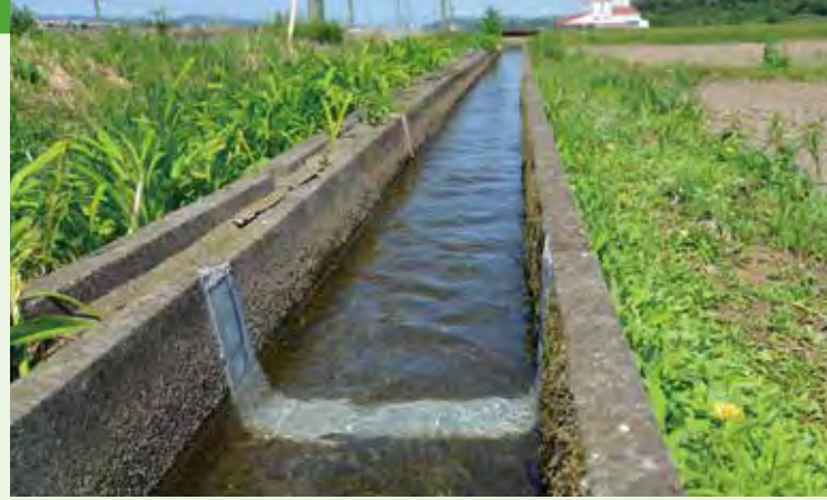
農業用小型開水路ジョイント部に貼り付けたアグリパッチシール
