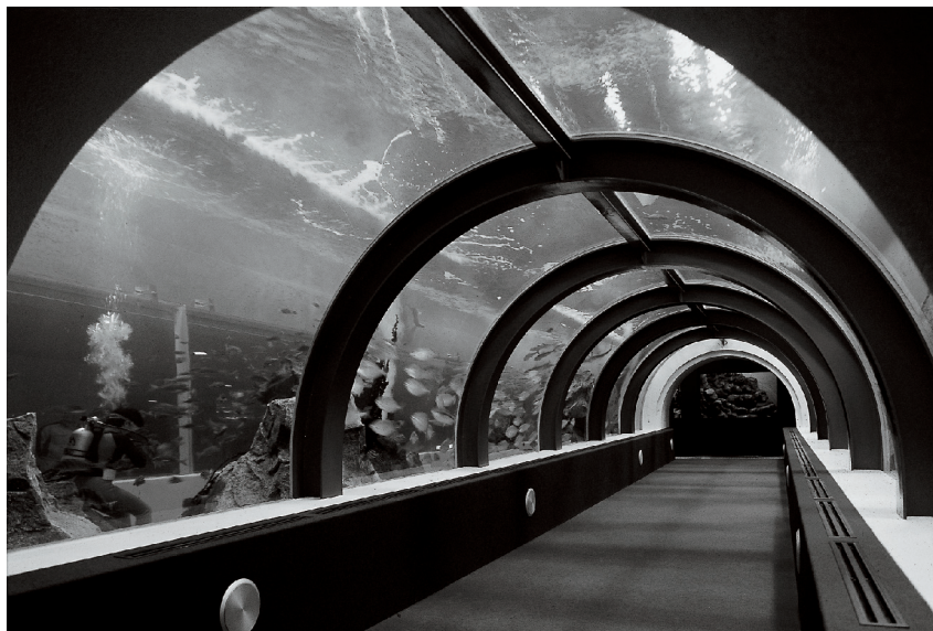
大型水槽の目地シール
