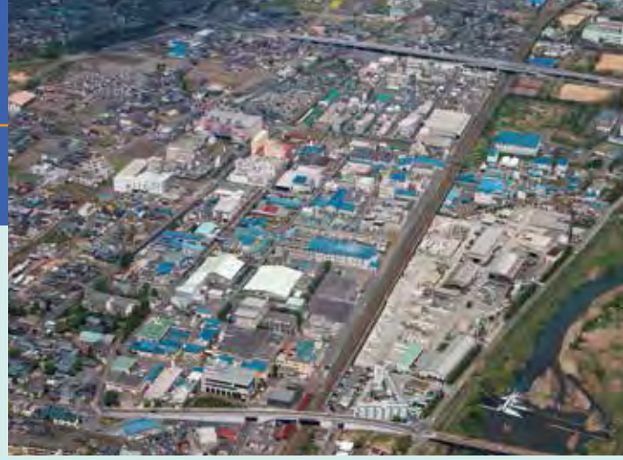
北陸本線JR武生駅に近い武生工場
