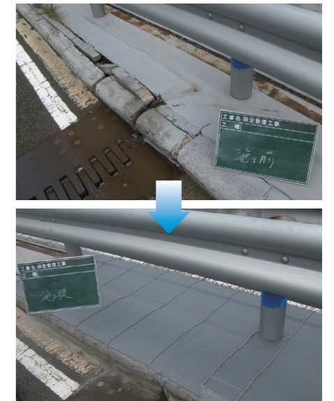
写真-4 道路の中央分離帯遊間(水平目地)の防水シール
