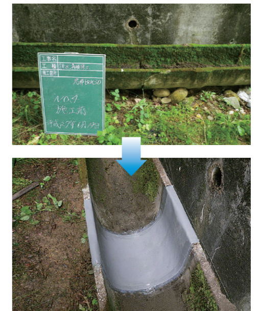
写真-5 道路の排水溝の補修
