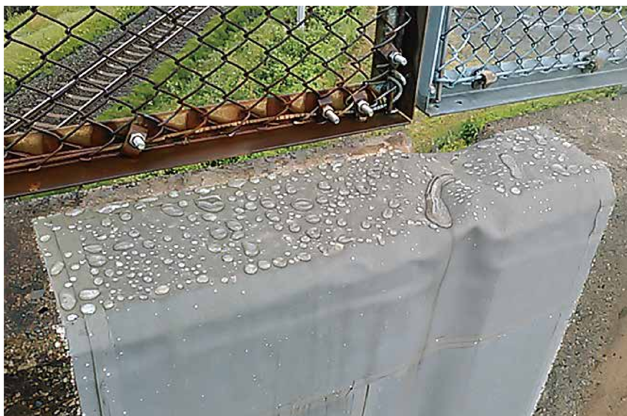
施工3年半経過後も雨水のはっ水性を維持
