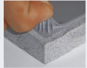
敷設後、端部を少し引き上げて、糸引き状態を確認してください。
