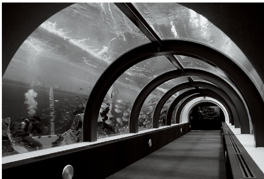
大型水槽の目地シール
