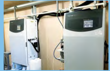
※TOC(Total Organic Carbon; 全有機炭素)計 TOC計 水中の有機物の量を炭素量を基に測定するもので、有機物による汚染の監視に使用されています。
