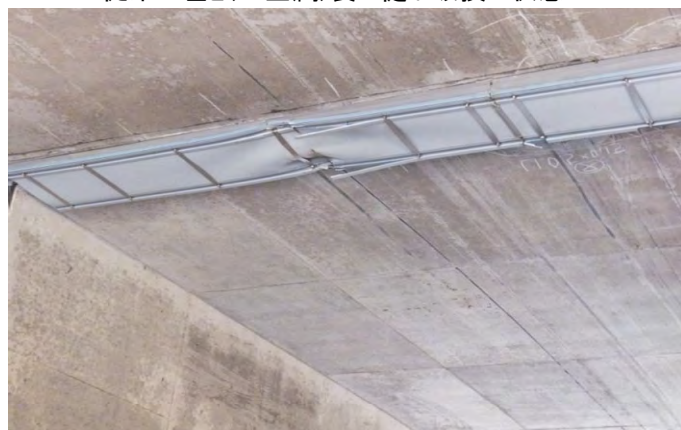
従来の塩ビ(+金属)製の樋が破損の状態
