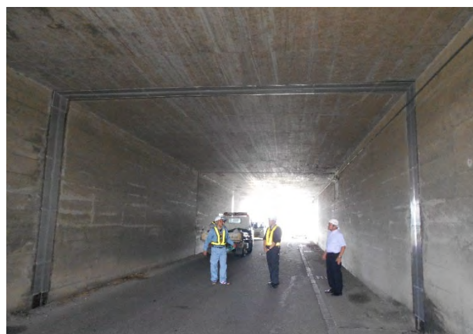
パッチシールクロスによる防水施工の完成状態
